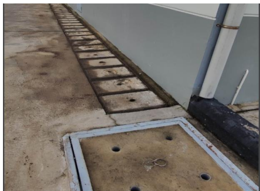
Mương thoát nước mưa hiện hữu
