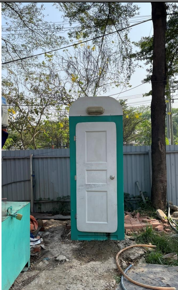
Hình 4.1. Nhà vệ sinh di động dự kiến tại khu vực xây dựng dự án
